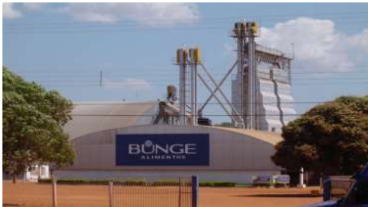
Figura 5: Fachada BUNGE Alimentos em Rio Grande
