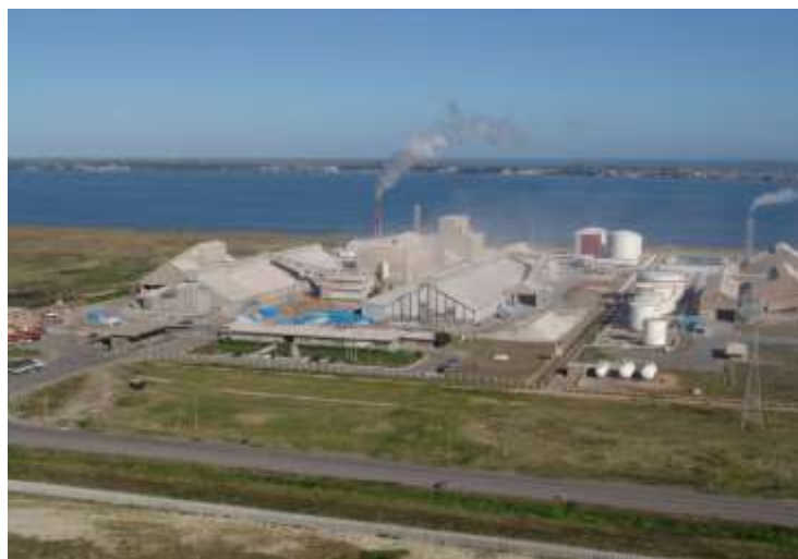
Figura 6: Parte do Complexo Empresa BUNGE Alimentos Rio Grande
