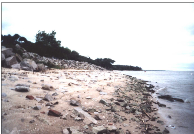
Figura 7 - Perda das pedras na obra emergencial na Praia do Barro Duro
