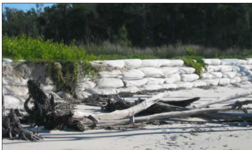
Figura 5 - Revestimento feito com sacos preenchidos com areia Fonte: www.waterways.nsw.gov.br
