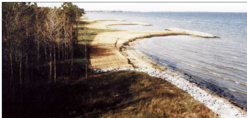
Figura 3 - Quebra mar segmentado construído na Baía de Chesapeake, EUA. Fonte: Hardaway e Byrne [7].
