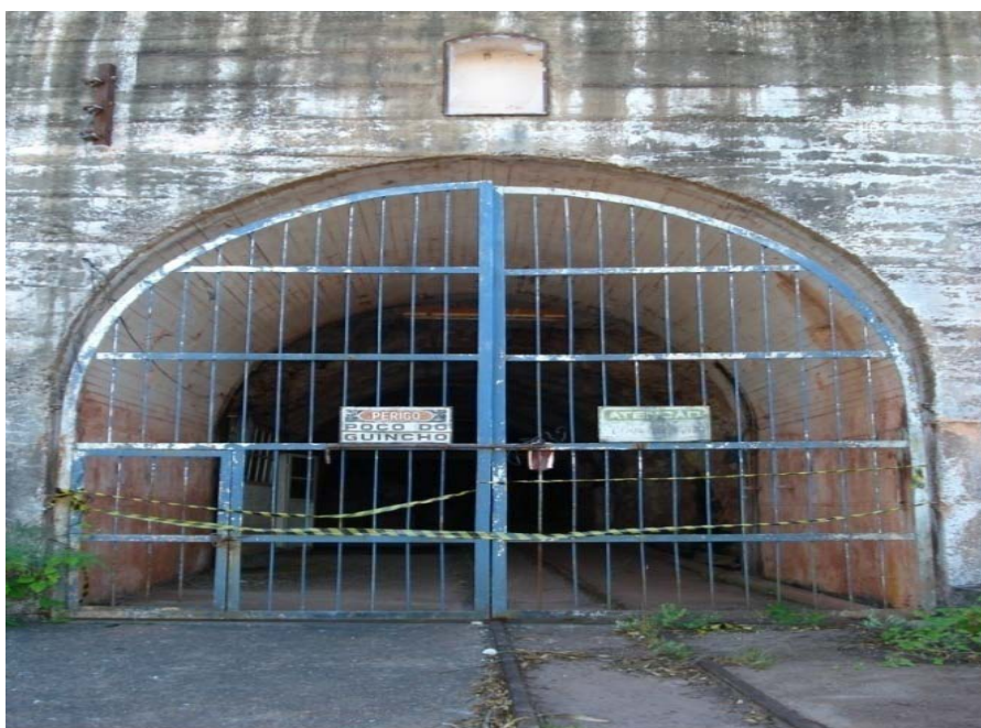
Figura 41: Galeria fechada Fonte: Acervo da pesquisadora
