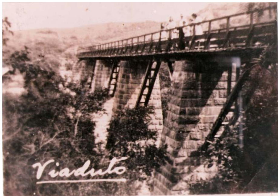
Figura 16: Viaduto por onde circulavam as vagonetas Fonte: arquivo CBC
