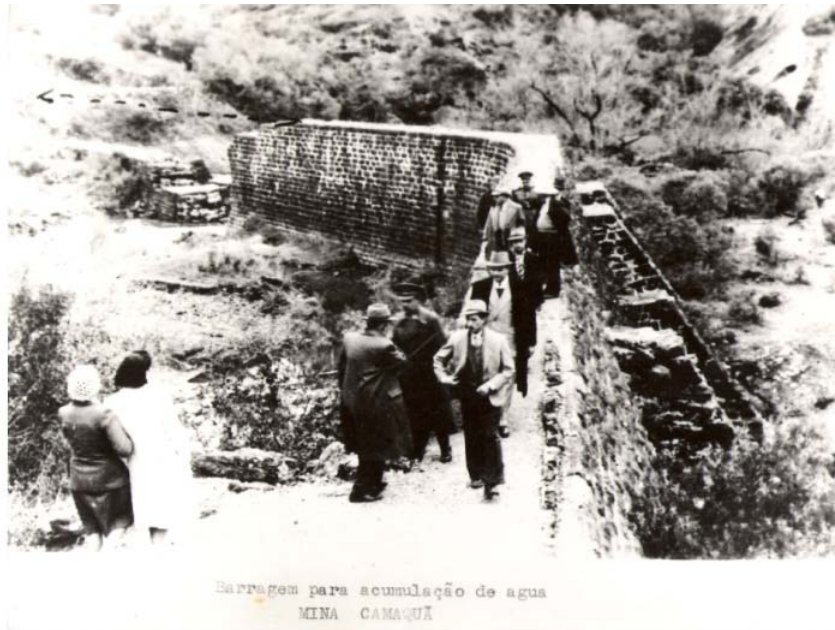
Figura 15: Construção da barragem pelos empresários belgas Fonte: Arquivo CBC
