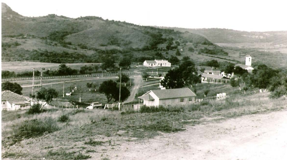
Figura 18: O armazém Fonte: Arquivo CBC
