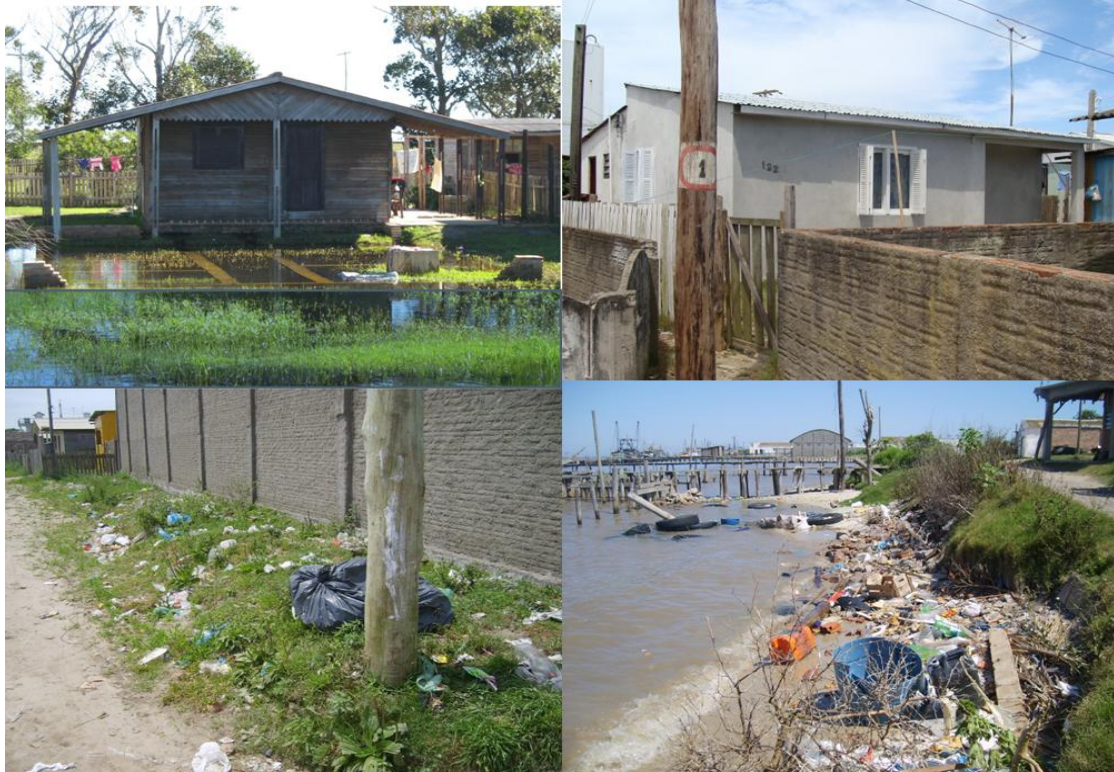
Figura 23: Problemas de infraestrutura na Localidade da Barra Velha em Rio Grande/RS.
