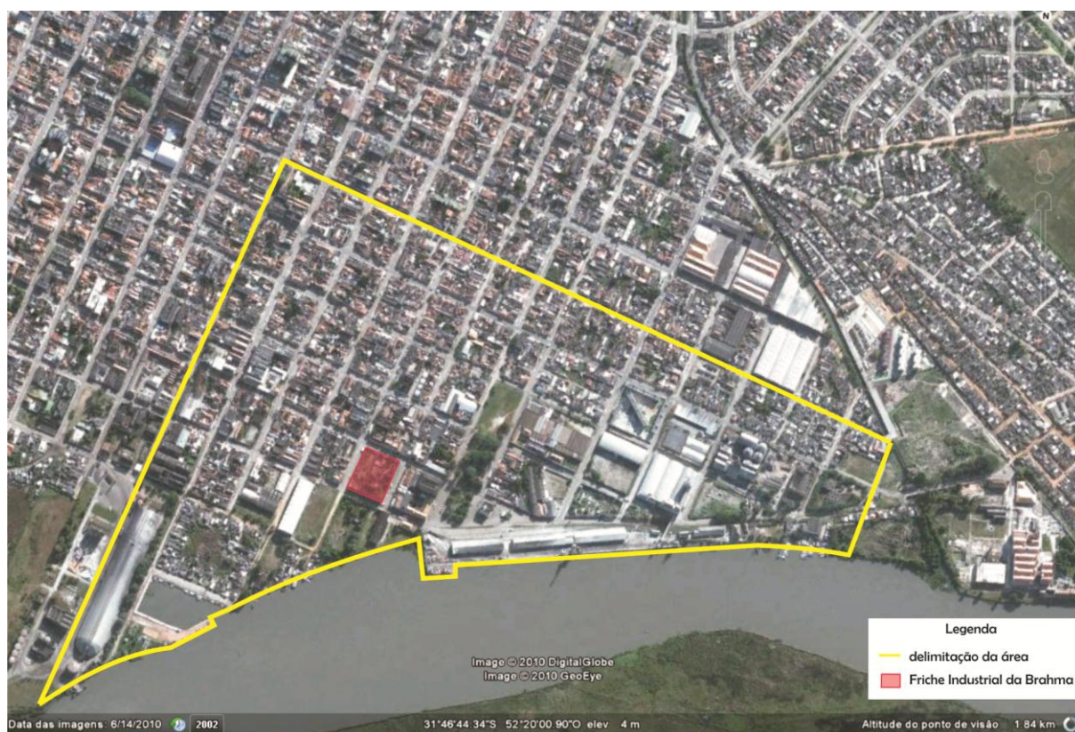
Figura 23 Localização da Friche Industrial da Brahma na espacialidade da Zona do Porto de Pelotas
