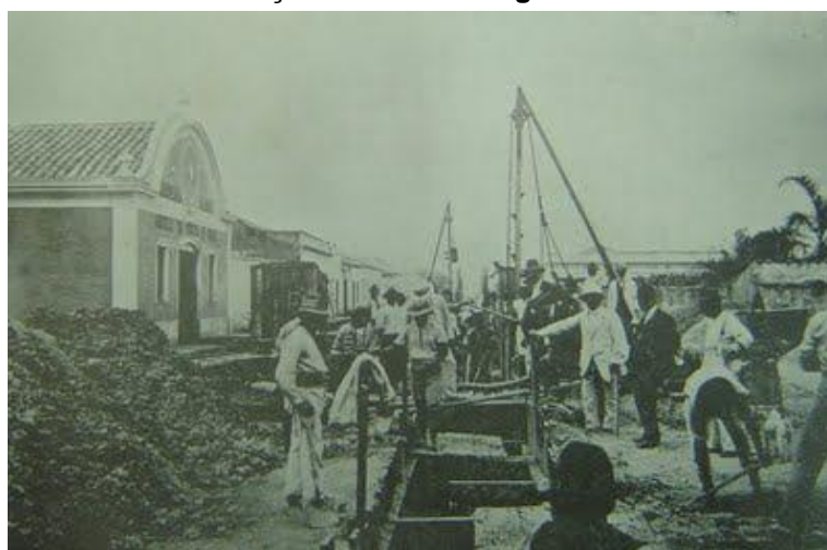
Figura 10 Construção da rede de esgotos em 1913.
