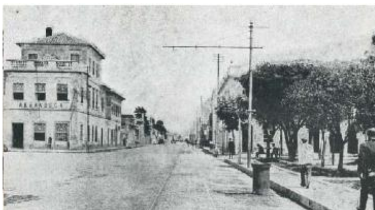
Figura 11 Trilhos de bonde elétrico na zona do porto.
