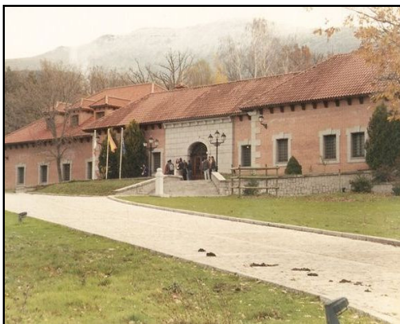
FIGURA 12 – Fachada do CENEAM
