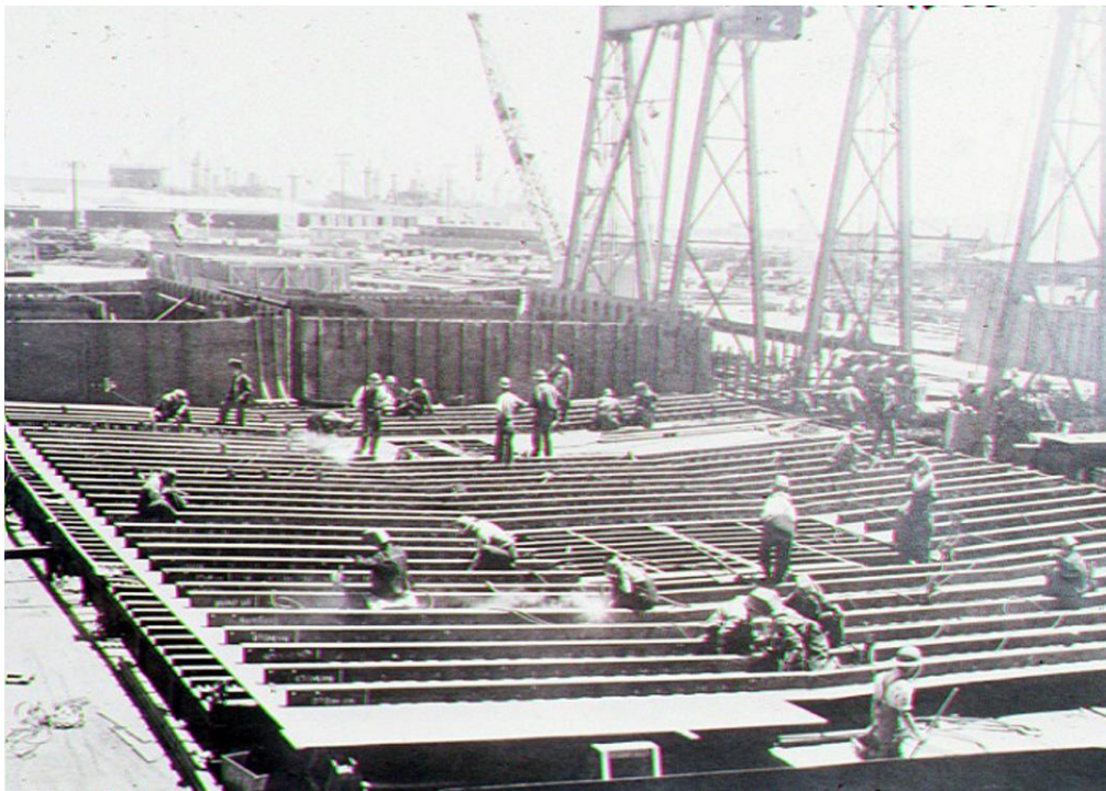
Figura 2.1 - Montagem no Dique Fonte: Brito; Gordo, 2006.
