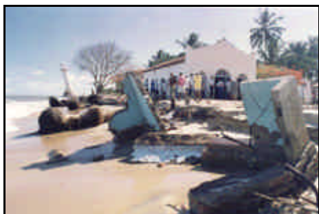
Figura 9. Igreja na Vila de Cabeço, com o farol já na linha de costa, em 1998. (Bandeira, 2005)
