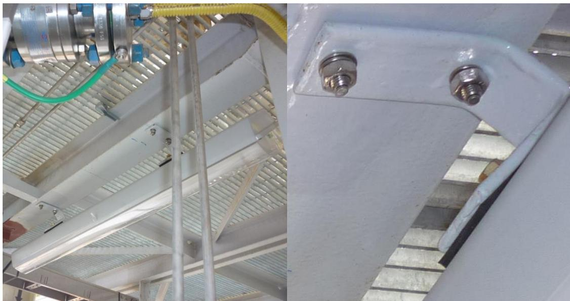
Figura 2 – Detalhe do uso dos pinos conectores utilizados em uma aplicação naval
