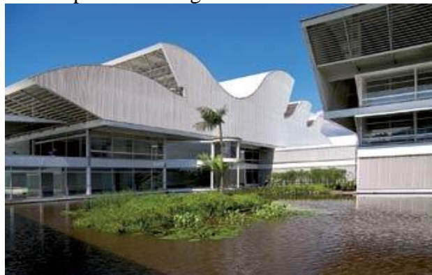
Figura 20 - Hospital Joao Filgueiras Lima, o auditório esférico e o solário são os elementos esculturais do projeto.
