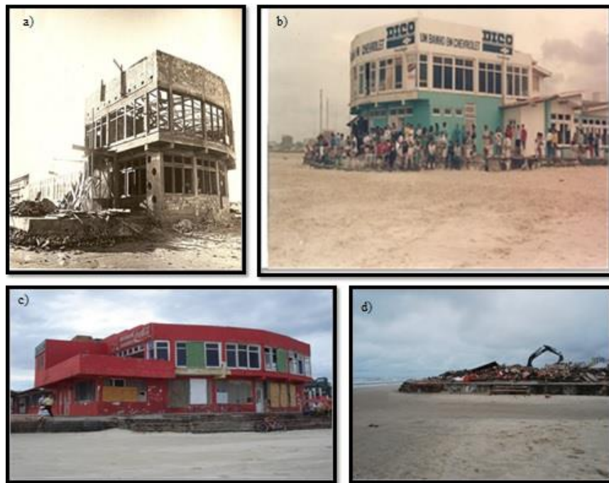
Figura 5 – Baronda em diferentes épocas - a) construção na década de 1970; b) sendo desfrutado por veranistas e moradores; c) interditado por decisão judicial e d) demolição em 2010.
