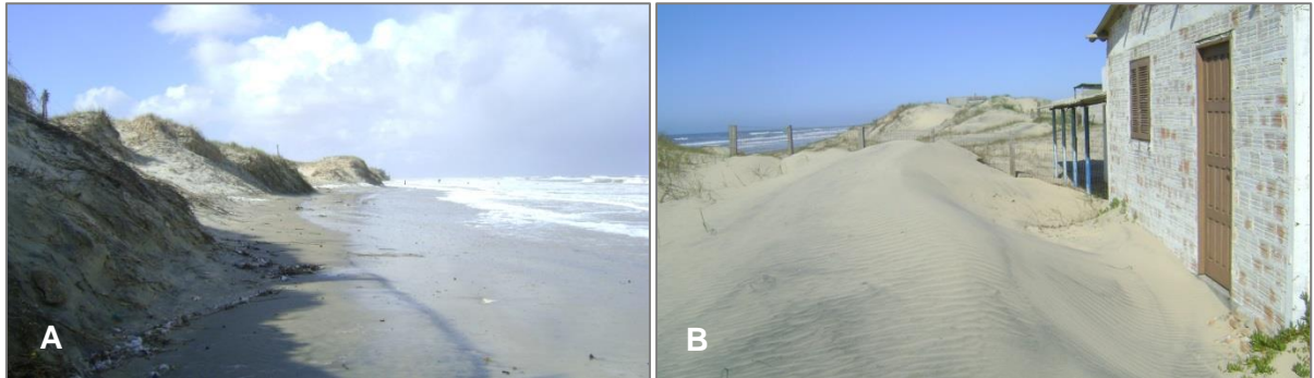
Figura 16: Trecho com dunas frontais (foto A) e invasão de areia sobre as edificações no Balneário Hermenegildo (foto B).
