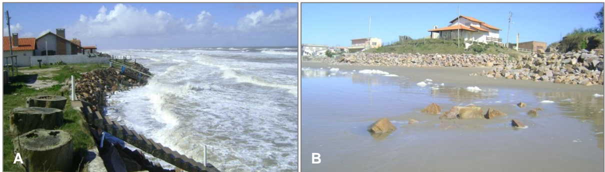
Figura 24: Foto A – impacto das ondas sobre as estruturas de contenção. Foto B – rochas que faziam parte de uma estrutura e foram desagregados durante a maré de tempestade.
