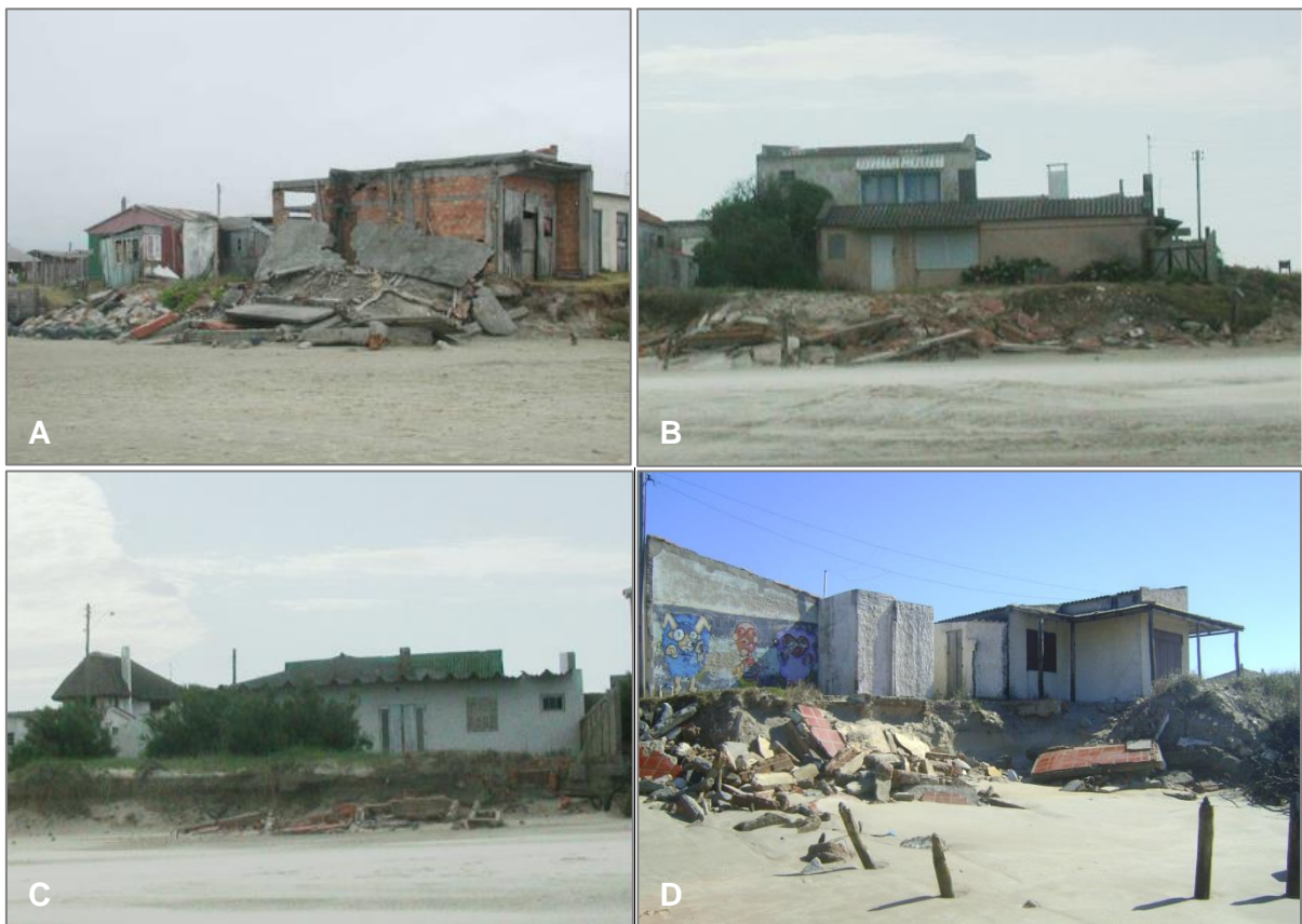
Figura 48: Edificações destruídas na orla do Balneário Hermenegildo. Fonte: Teixeira, 2007 (fotos A, B e C).
