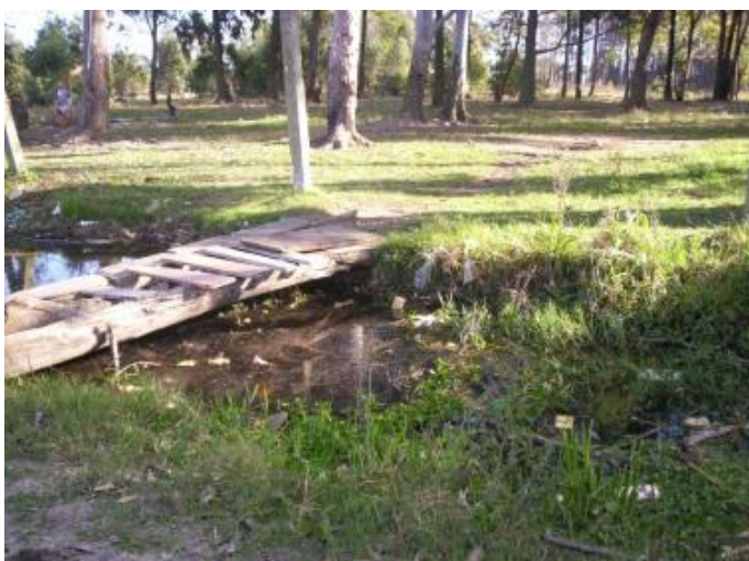
Figura 37 - desaparecimento da cerca que limita o campus do bairro vizinho e a construção de uma ponte sobre a vala de drenagem do campus . Vestígios comportamentais da comunidade do entorno. Foto da pesquisadora, 2010.
