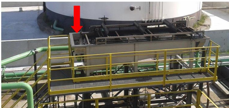
Figura 7 - Local de amostragem do efluente, saída do Flotador a Ar Dissolvido (FAD) da Refinaria de Petróleo Riograndense.
