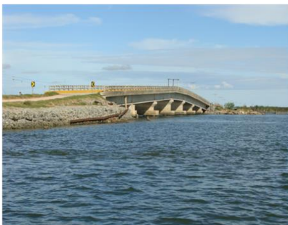
Figura 5 – Ponte Wilson Matos Branco Fonte: A autora, 2014
