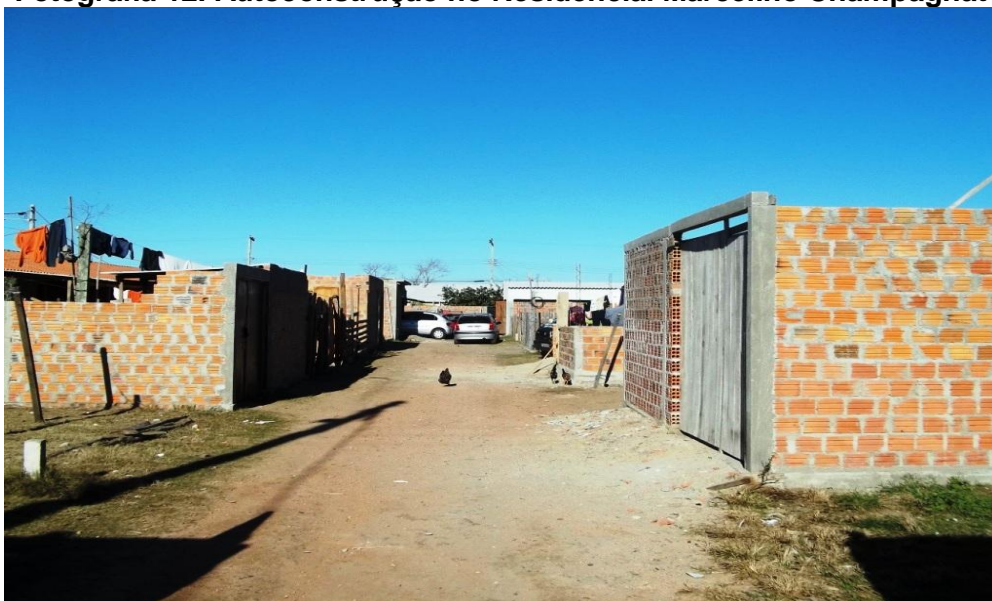
Fotografia 12. Autoconstrução no Residencial Marcelino Champagnat
