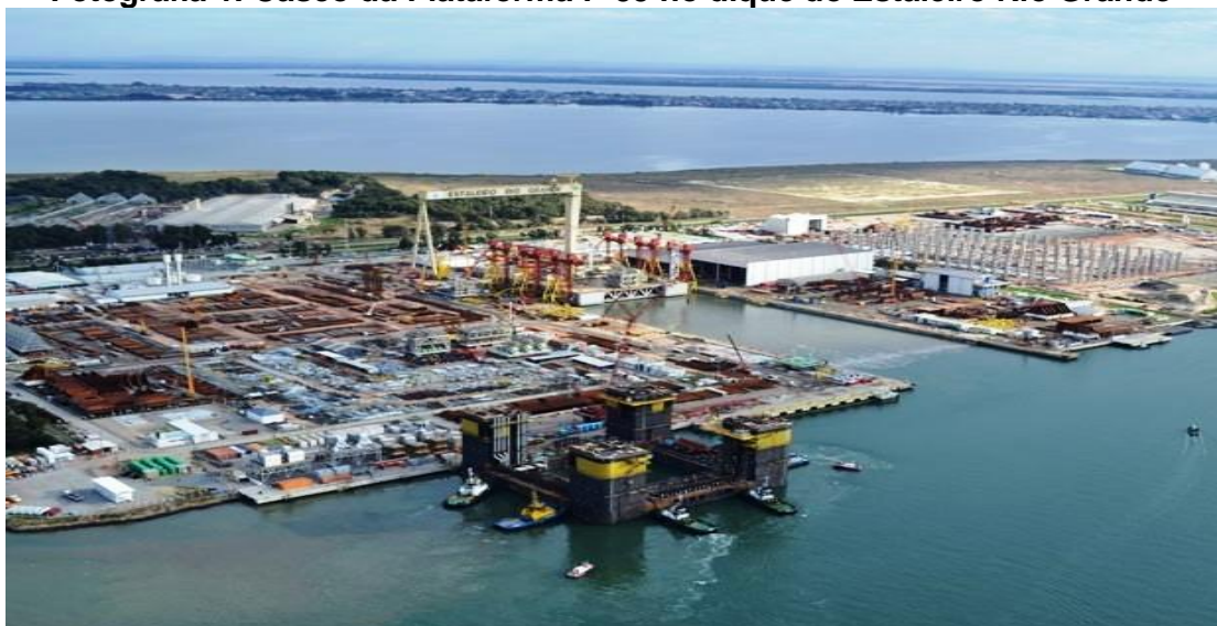
Fotografia 1. Casco da Plataforma P-55 no dique do Estaleiro Rio Grande
