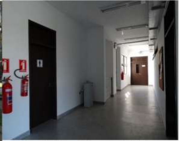
Parte interna do prédio construído para as salas de aula.
