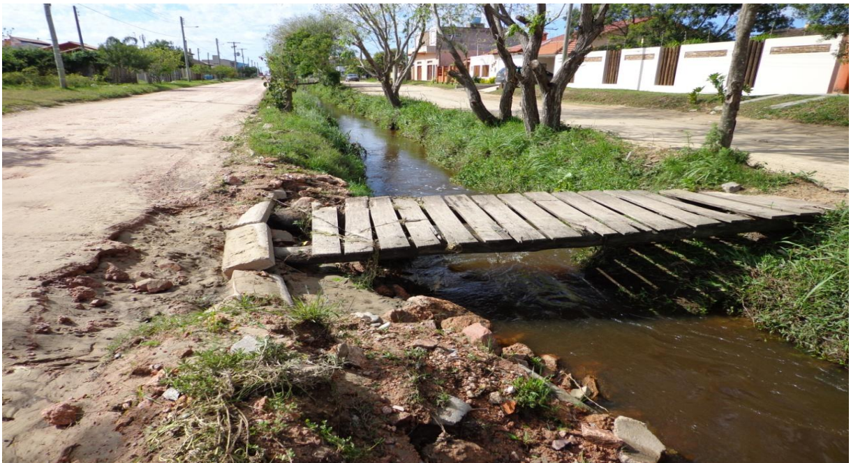
Figura 33: Surgimento de deslizamentos na margem do sangradouro do Gelo após precipitação em 16/10/2015. Foto: A autora.
