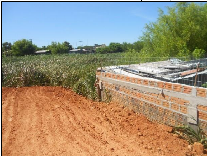
Figura 44: Coberturas de FIFL sendo aterradas para a expansão urbana.
