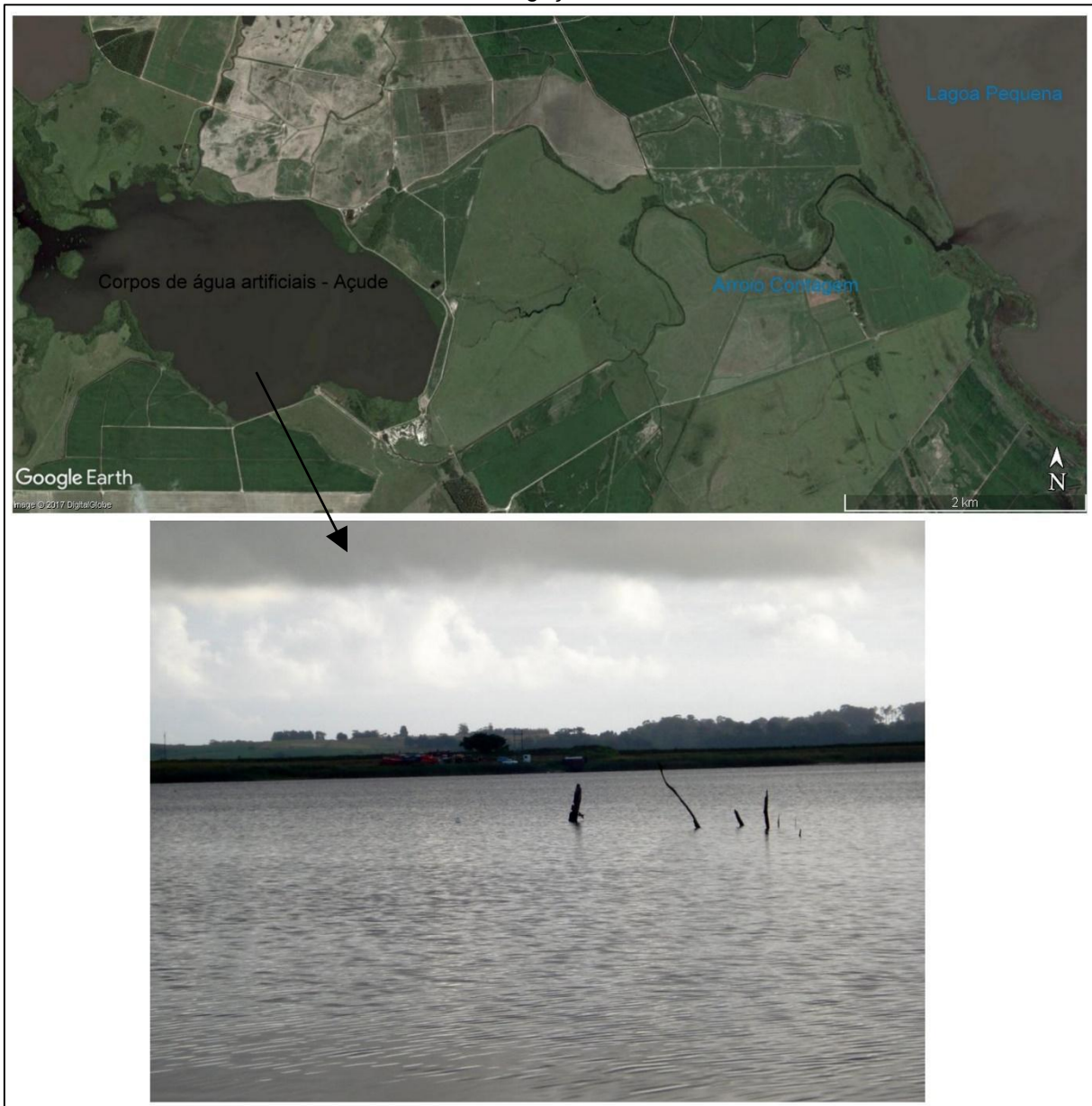
Figura 10: Deságue do Arroio Contagem na Lagoa Pequena, e imagem da represa construída para irrigação.
