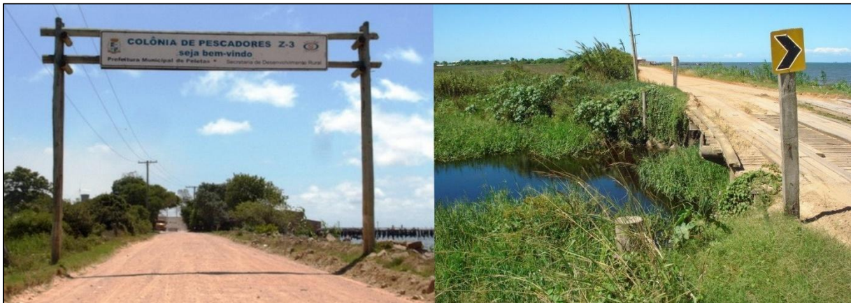
Figura 21: Imagem à esquerda estrada de acesso (Figura 18) a Vila-sede, imagem à direita ponte da estrada de acesso sobre o canal Reasilva.
