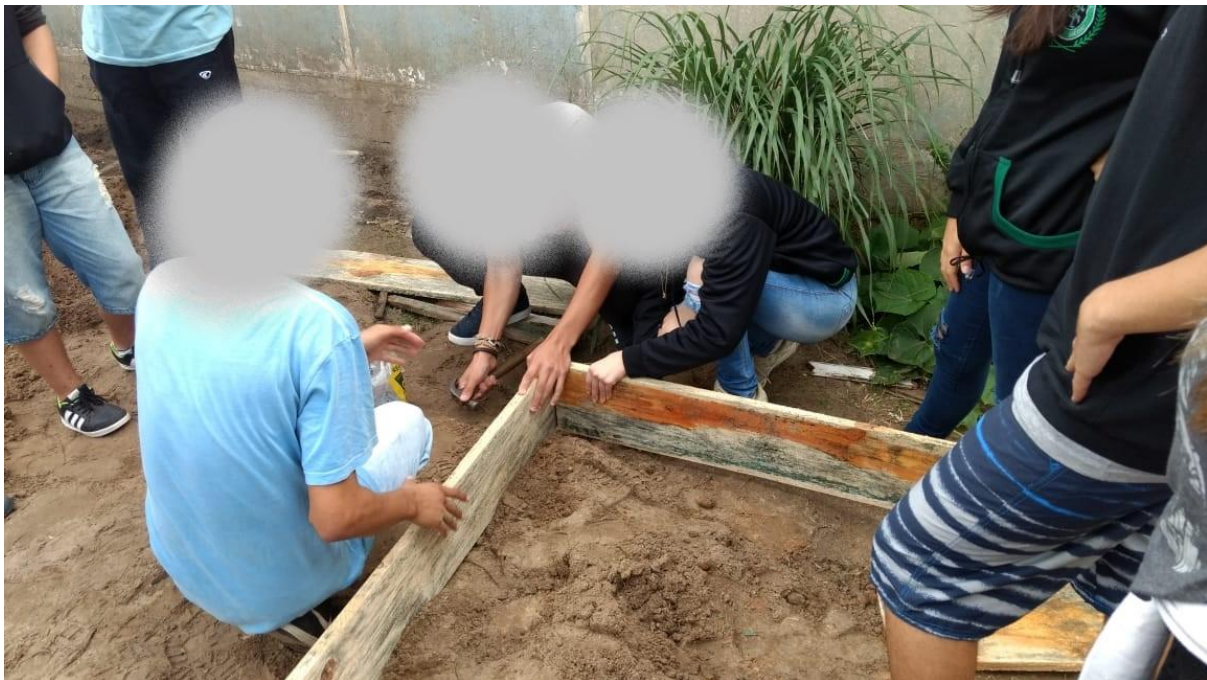
Figura 3: Montagem da base de uma das estufas
