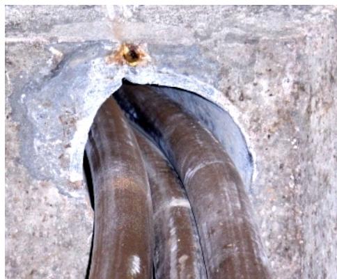
Figura 3.1: Corte em um cabo utilizado na distribuição subterrânea de energia.
