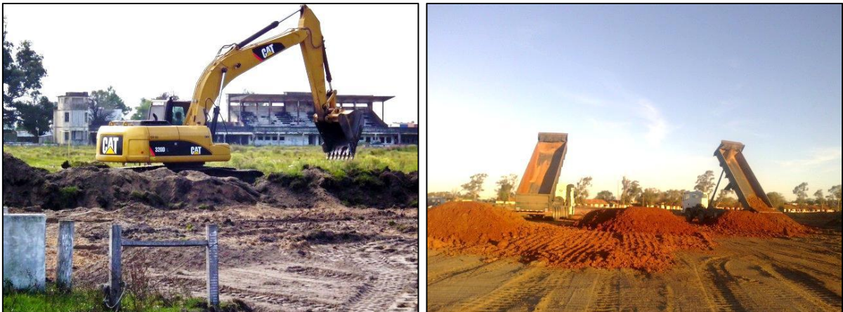
Figura 14 - Início das obras de terraplanagem.
