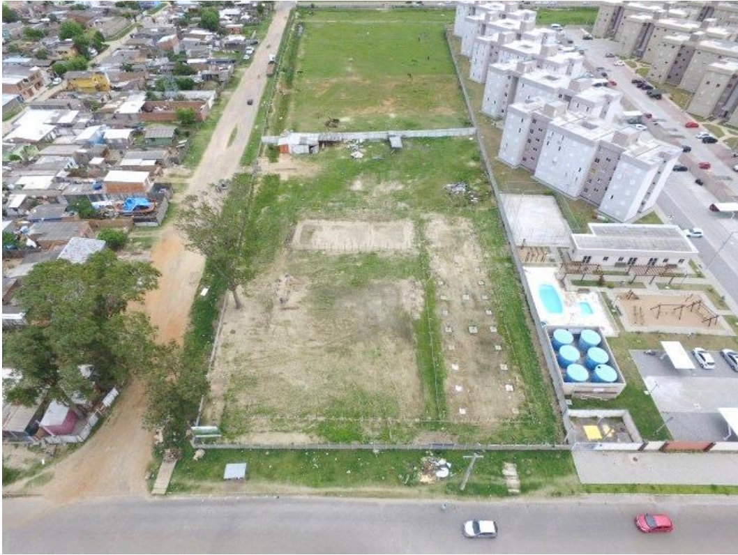
Figura 19 - Início das obras de construção do CEU.
