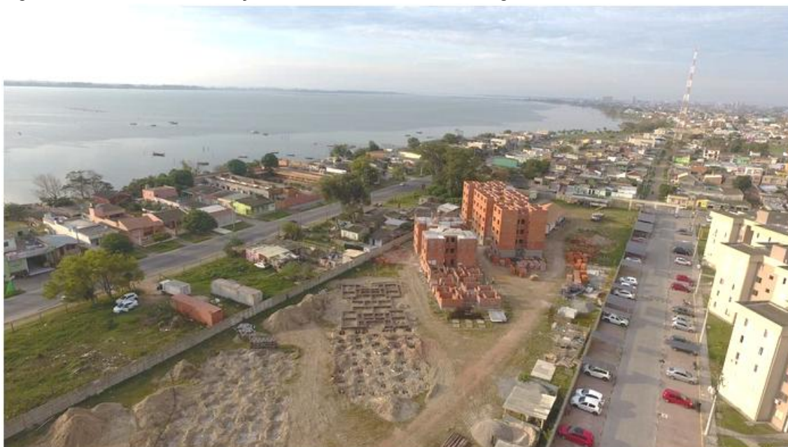
Figura 17 - Obras de construção do Residencial Solar da Lagoa.
