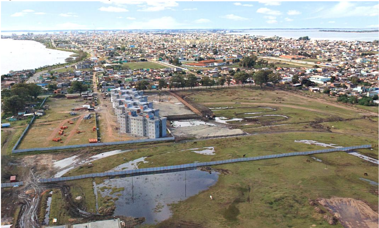
Figura 16 - Obras de construção do Residencial Jôquei Clube I.
