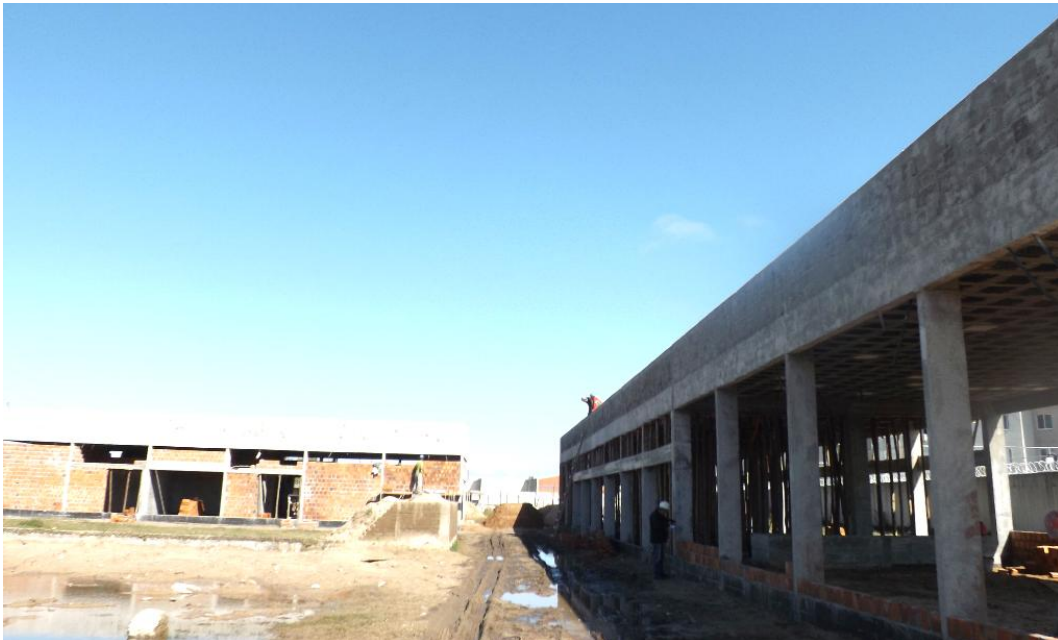
Figura 20 - Obras de construção do Centro Unificado de Artes e Esportes.
