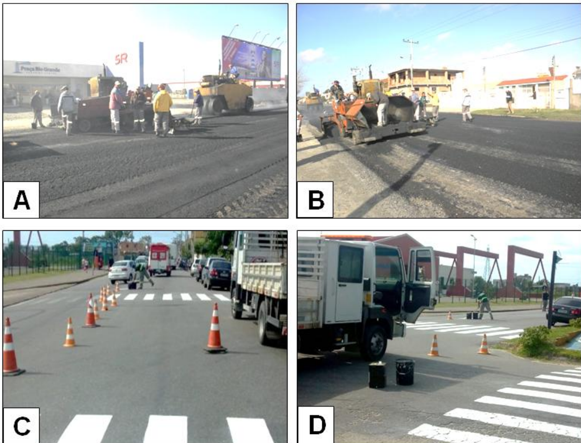
Figura 21 - Rua Saturnino de Brito. Obras de asfaltamento e sinalização.
