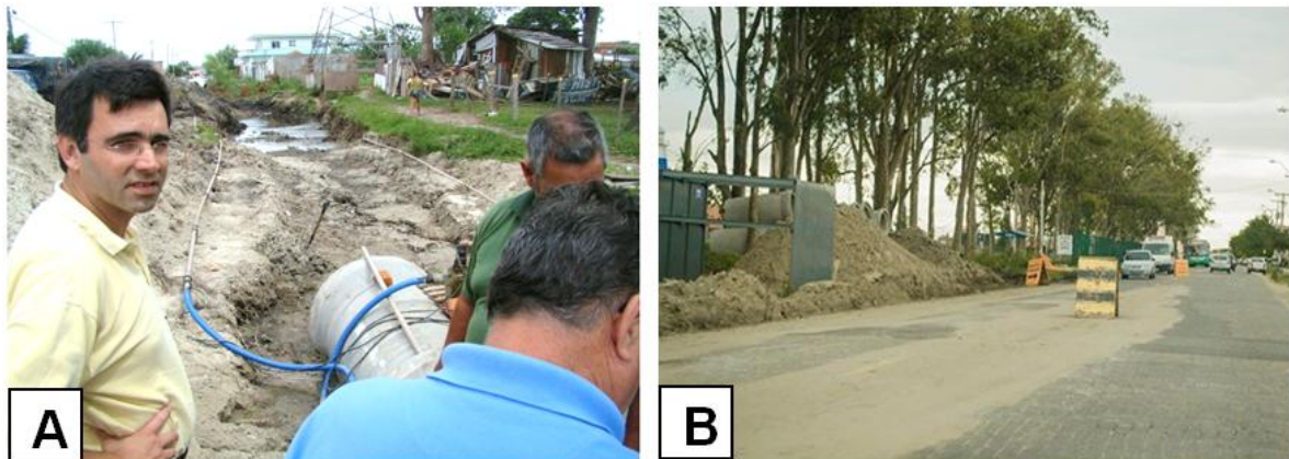
Figura 22 - Obras de drenagem pluvial, ruas Pedro de Sá Freitas e Jockey Clube.
