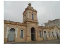
Prédio da Alfândega
