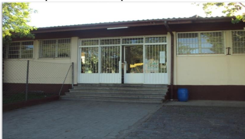
Figura 1: Foto do portão de acesso à parte administrativa.
