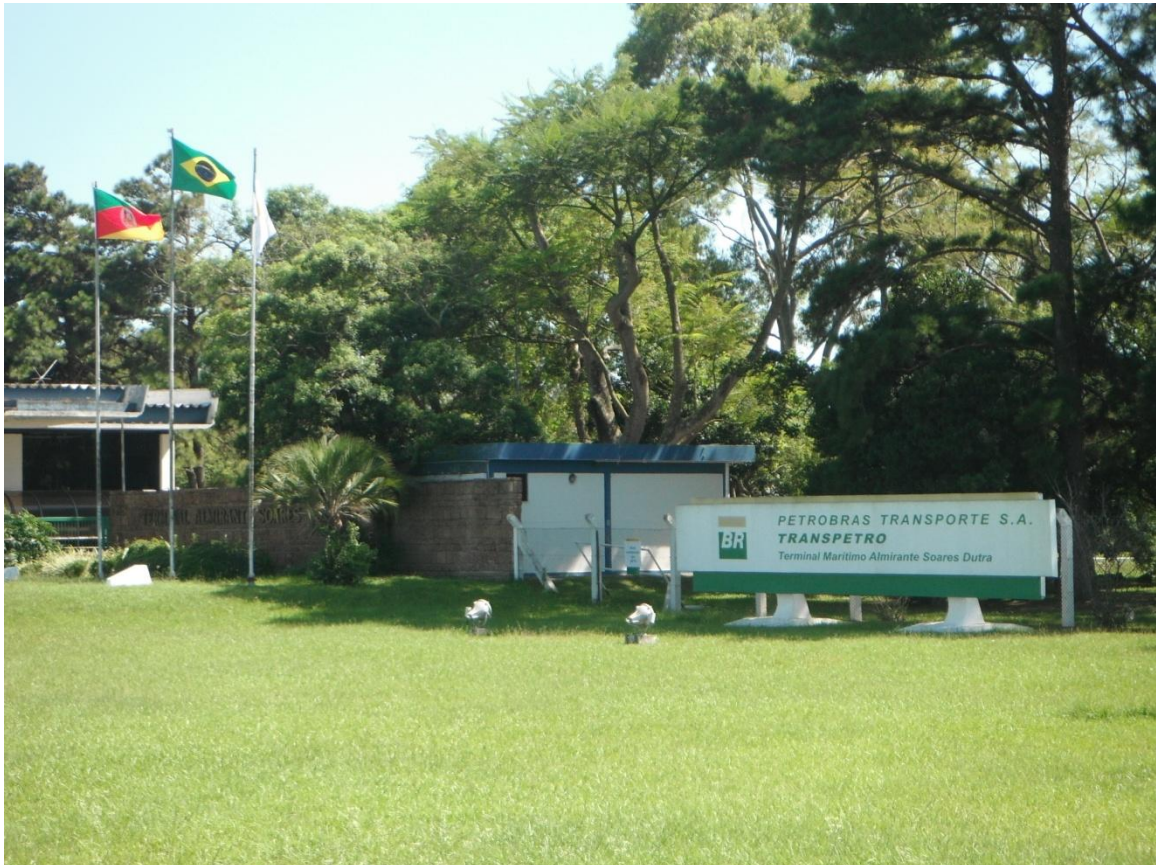
Figura 5. Terminal da TEDUT em Tramandaí.
