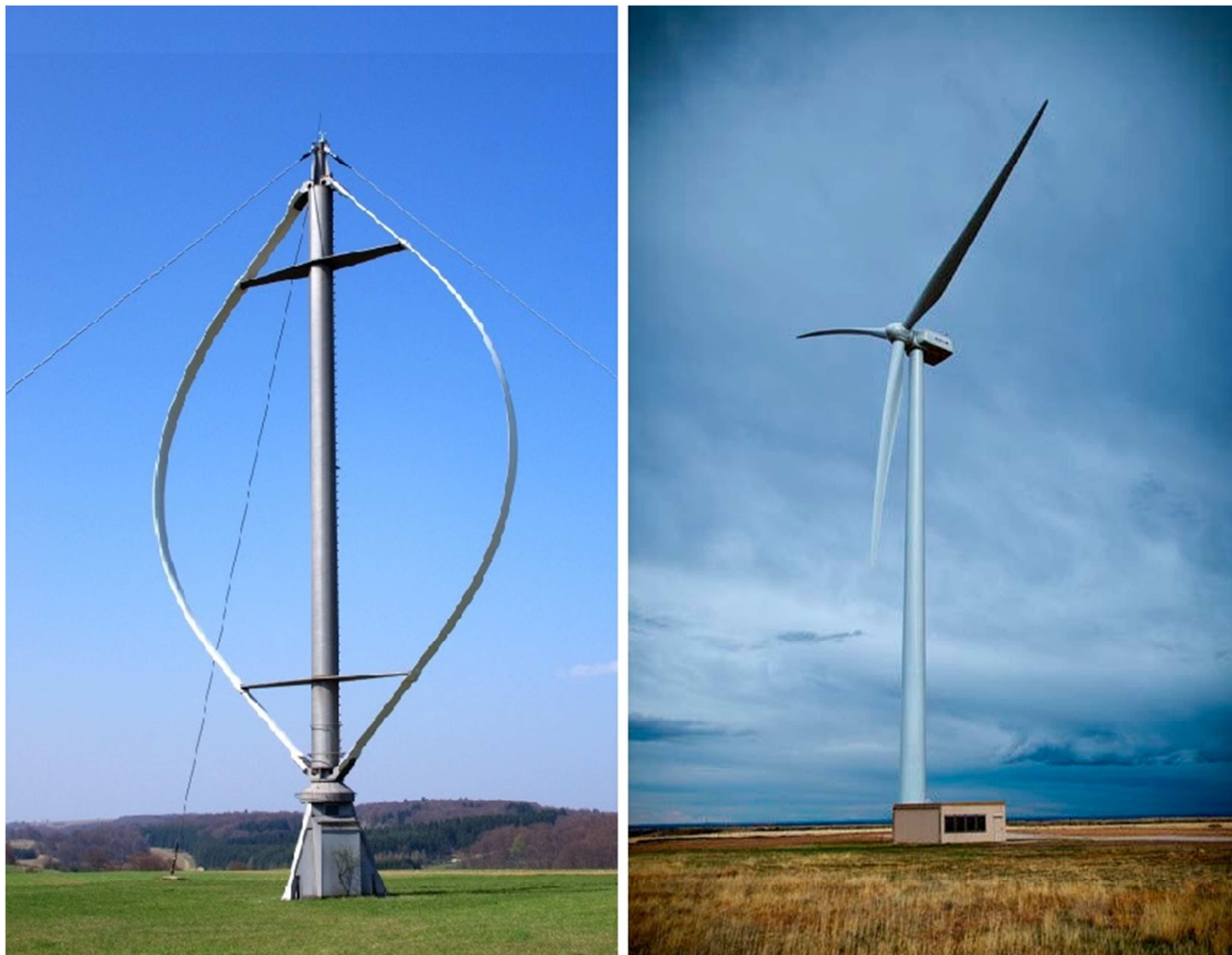
Figura 4-3 – Exemplo de turbina eólica de eixo vertical e de eixo horizontal. Fonte: PUC RS – CE-Eólica.
