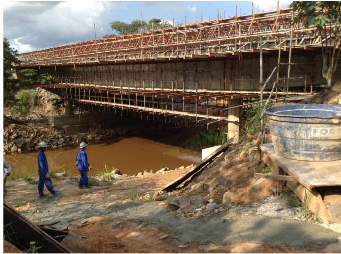
Figura 2.3 - Ponte sobre o Rio Joanes (Alpe Estruturas)
