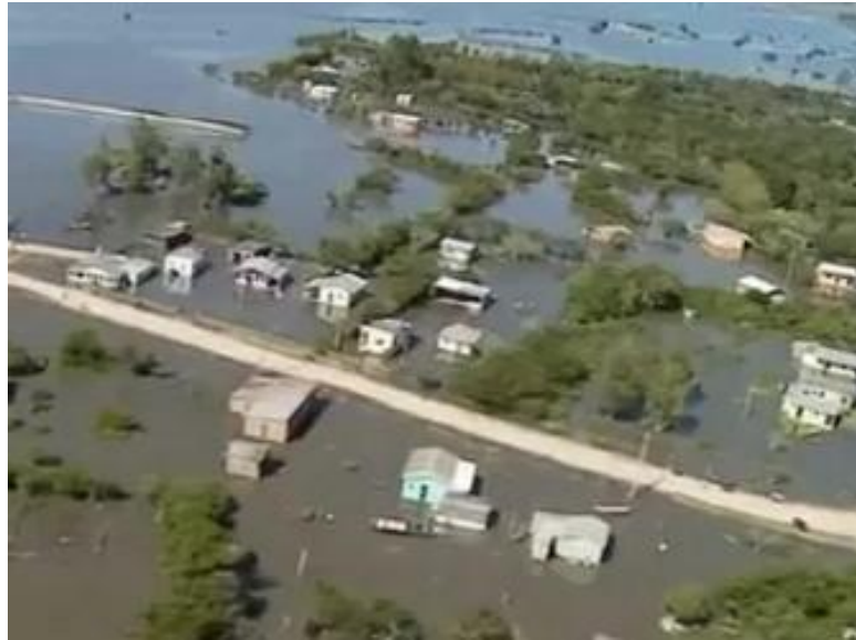
Figura 3.4. - Inundação na Ilha dos Marinheiros
