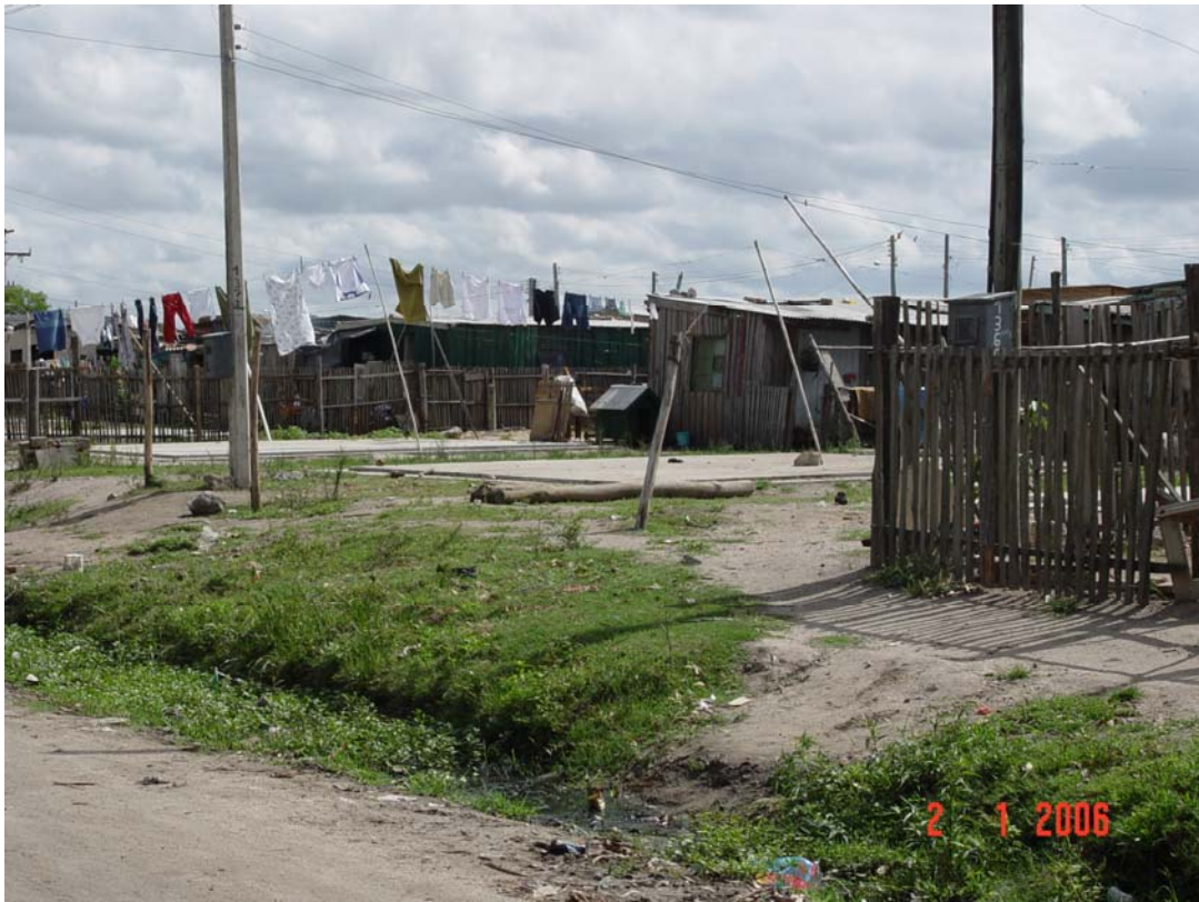
Vista das primeiras bases de concreto
