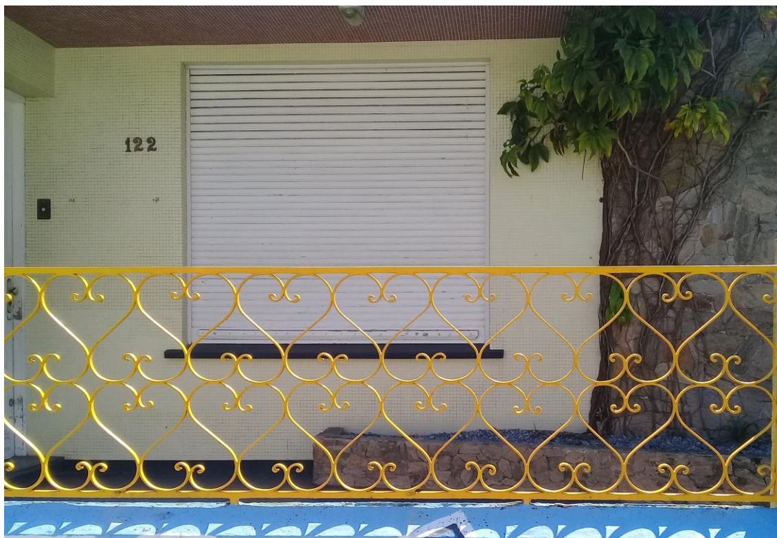
Fig. 42 - Gradeamento de residência em Rio Grande. Fotografia da autora, 2018.
