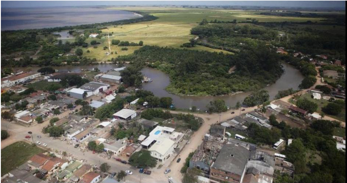
Figura 28: Rio São Lourenço depois da enchente por Eduardo Seidl
