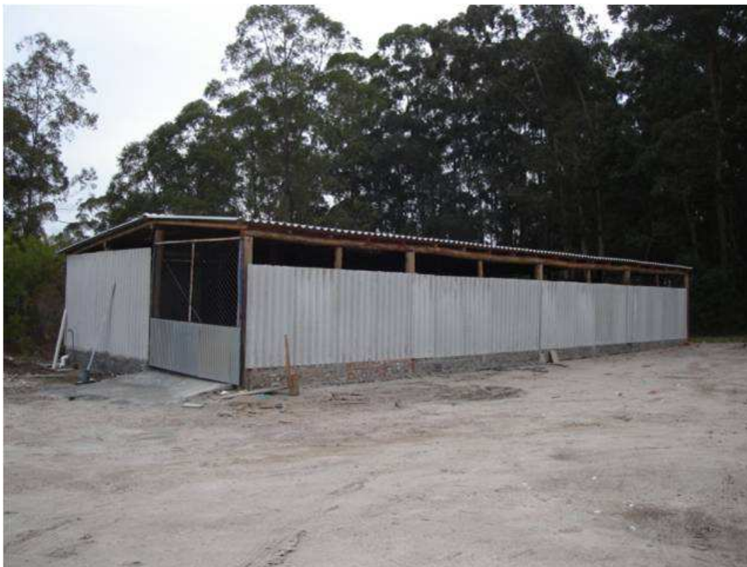
IM 3 – Central de Resíduos - Campus Capão do leão Fonte: CGA/UFPeI, 2009
