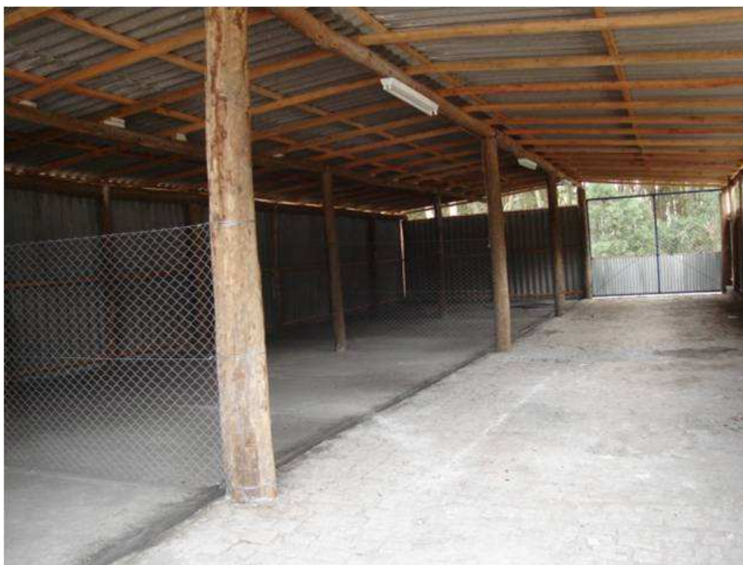
IM 4 - Central de Resíduos Campus Capão do Leão Fonte: CGA/UFPeI, 2009
