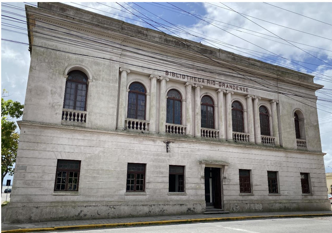
Figura 3 – Prédio da Biblioteca Rio-Grandense atualmente
