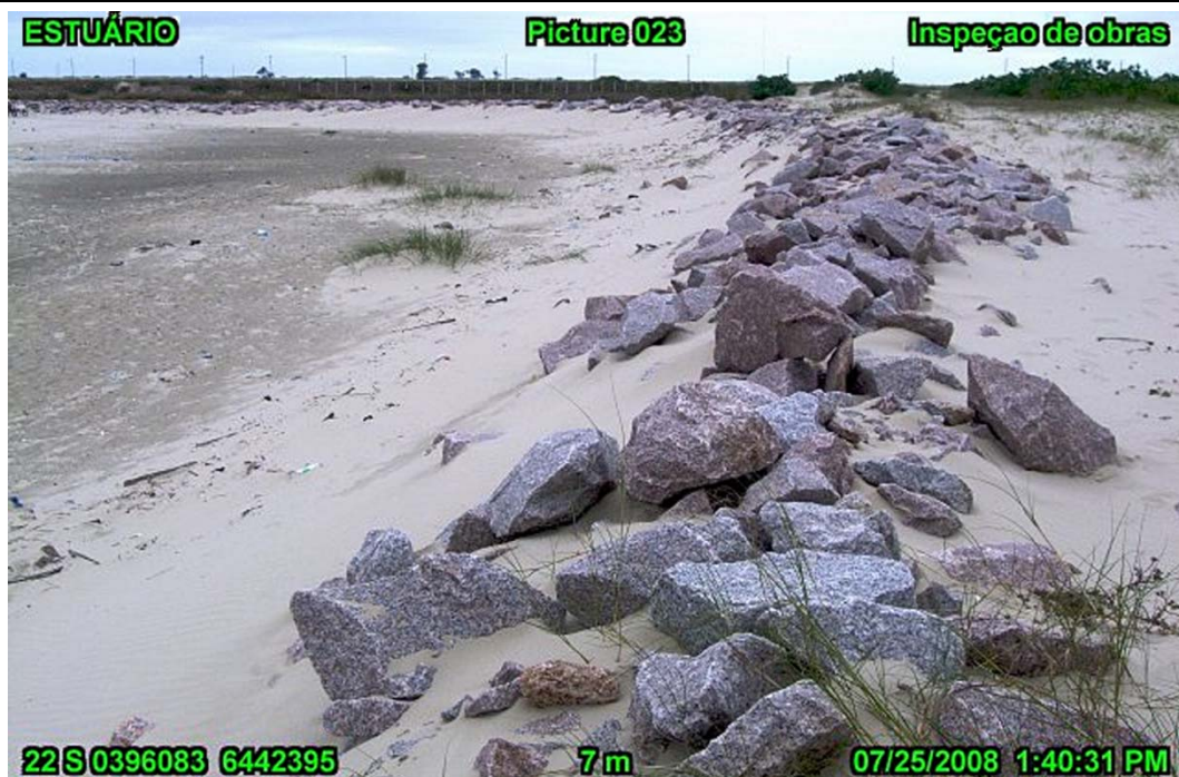
Figura 2. Foto georreferenciada de um enrocamento sendo construído na base do molhe oeste de Rio Grande-RS.
