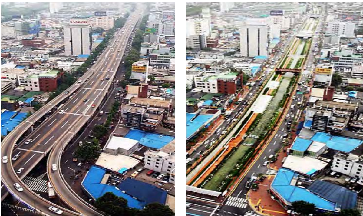
Figura 2. O Cheonggyecheon em Seul, antes e depois da revitalização. Fonte: NOH, 2010.
