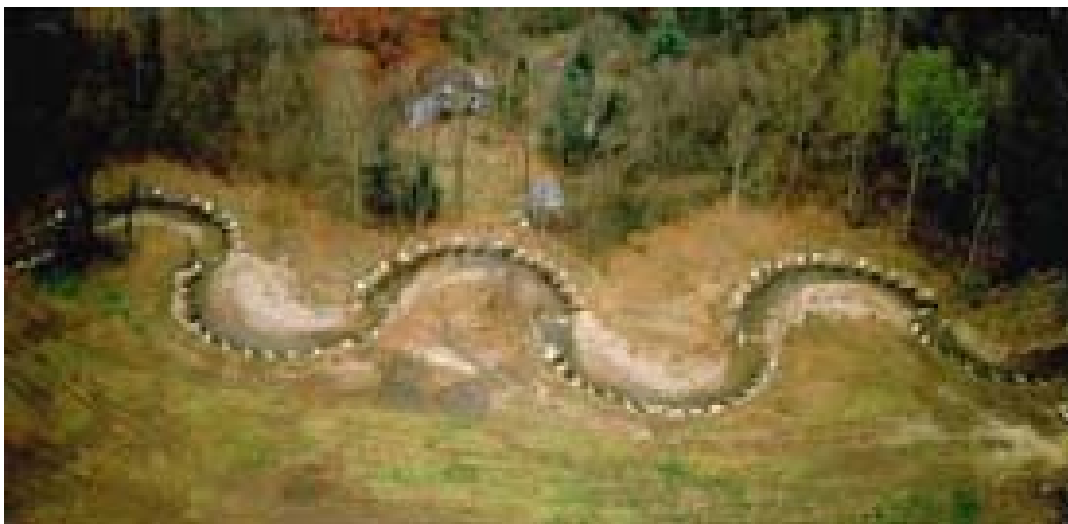
Figura 6. Revitalização de córrego baseada no modelo do Natural Channel Design . Fonte (PALMER, 2009)
