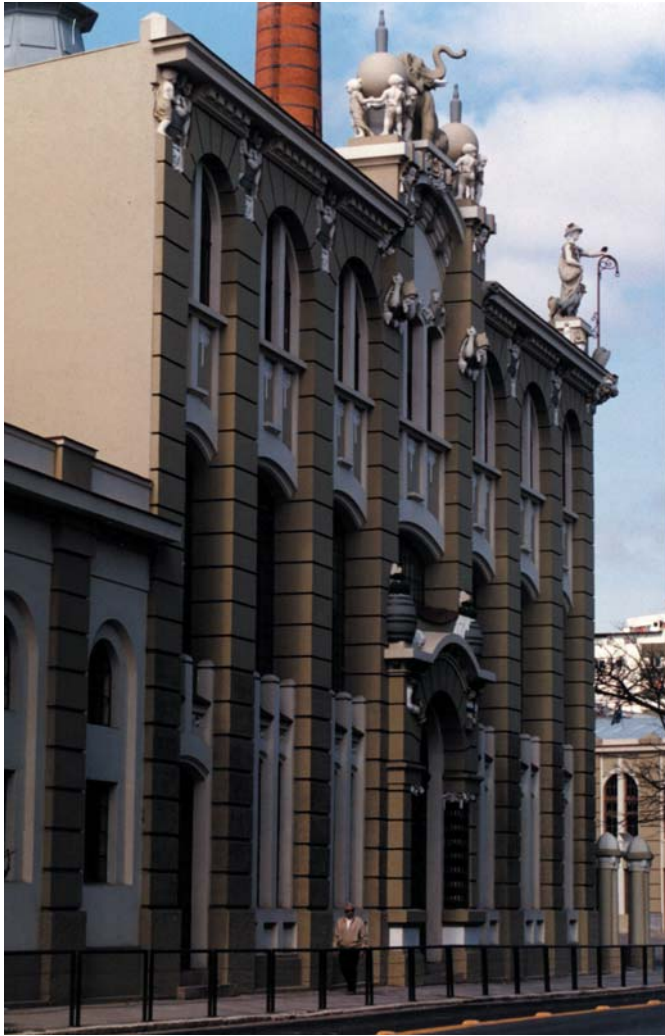
Figura 3 – Fachada do Prédio 1 da Cervejaria Bopp & Irmãos, fotografia de Lúcio Lorde.
