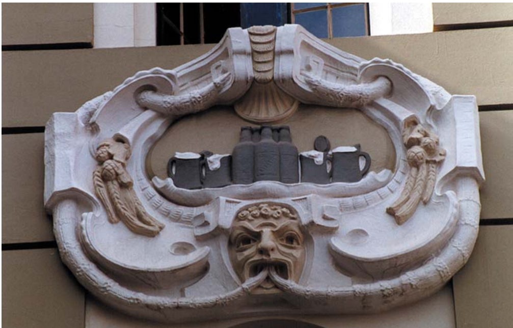
Figura 19 – Conjunto na parte central da estrutura de ligação entre os Prédios 1 e 2, fotografia de Lúcio Lorde.
