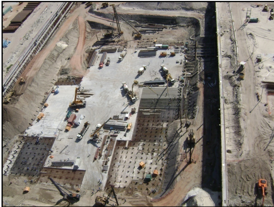
Figura 5.1 – Concretagem da laje de fundo do dique seco
