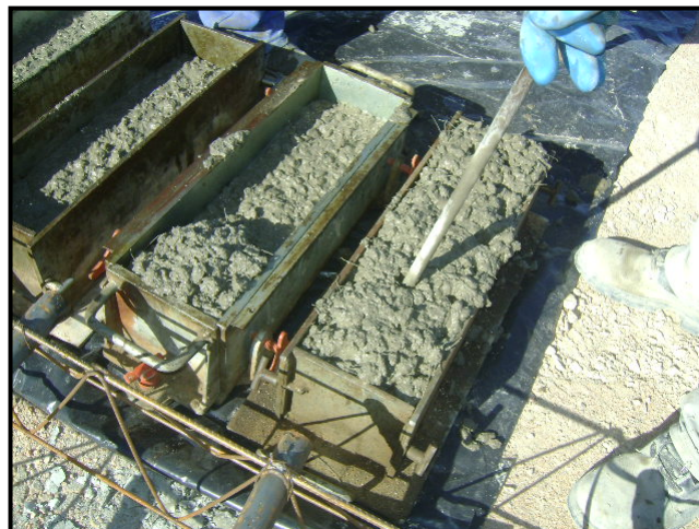
Figura 3.4 – Moldagem de corpos de prova prismáticos de concreto
