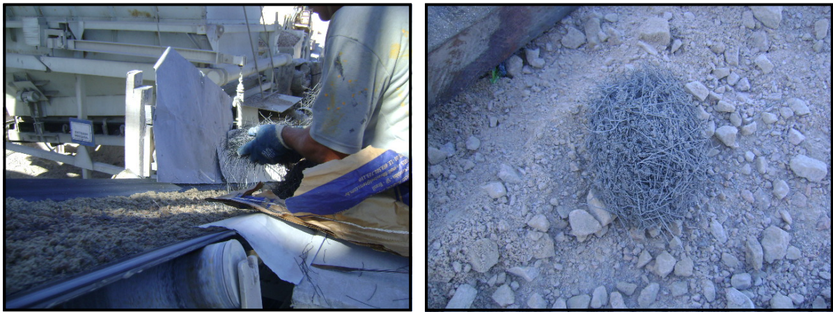
Figura 4.6 – Cuidados na dosagem das fibras no concreto e exemplo deformação de ouriços
