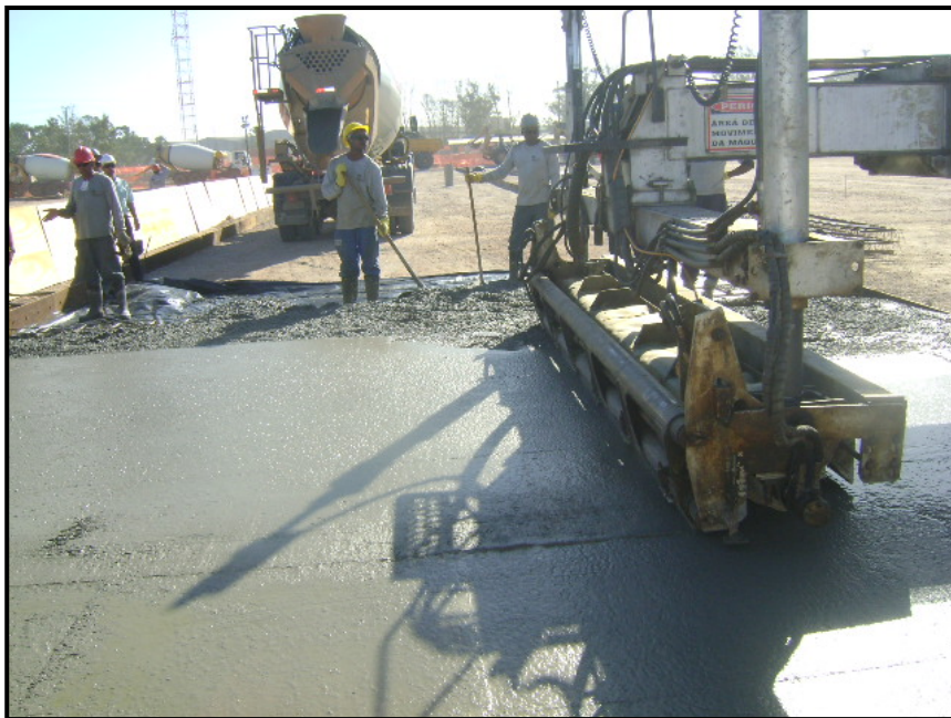
Figura 4.3 – Execução do piso industrial da área de pré-edificação do estaleiro com utilização de CRF
