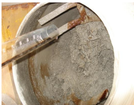
Fig. 3.10 – Adição de aditivo plastificante ao concreto.
