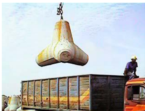
Fig. 2.14 – Tetrápode de 8 toneladas sendo içado (GUIMARÃES, et al., 2003).
