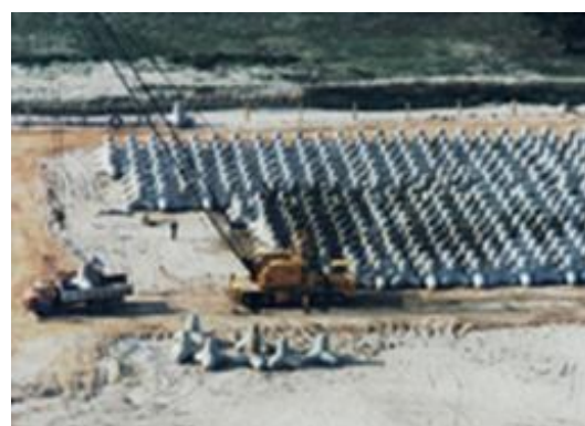
Fig. 2.16 – Tetrápode em condição de transporte (RIMA, 1999).
