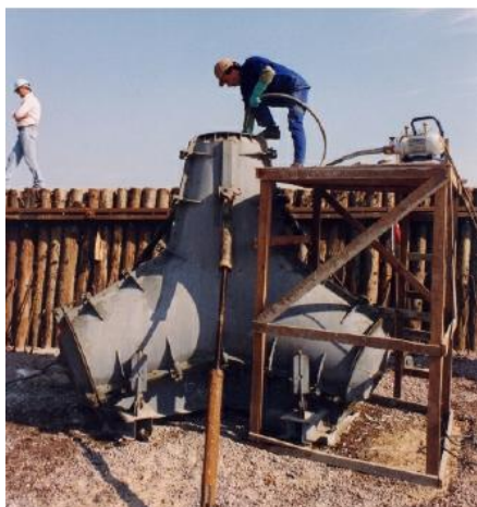
Fig. 2.12 – Vibração durante a concretagem (RIMA, 1999).
