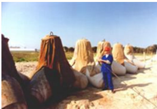
Fig. 2.15 – Tetrápode em processo de cura úmida (RIO GRANDE VIRTUAL, 2009).
