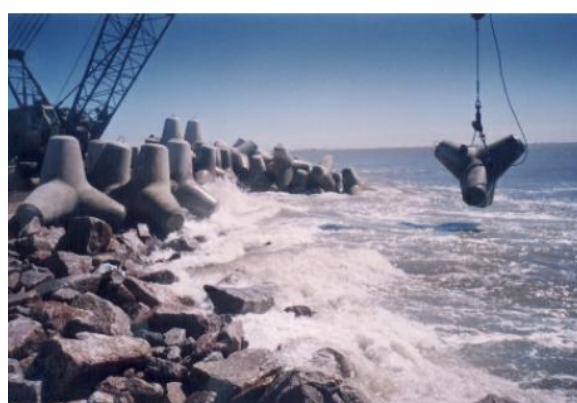
Fig. 2.18 – Processo de alinhamento. (RIMA, 1999).
