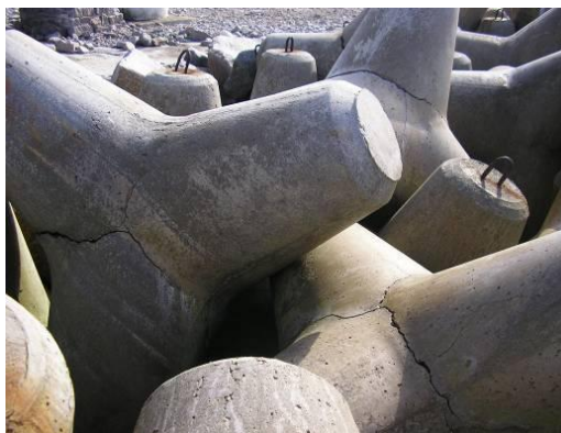
Fig. 2.24 – Blocos rachados interligados e sem pedras (MIGLIORINI, 2007).
