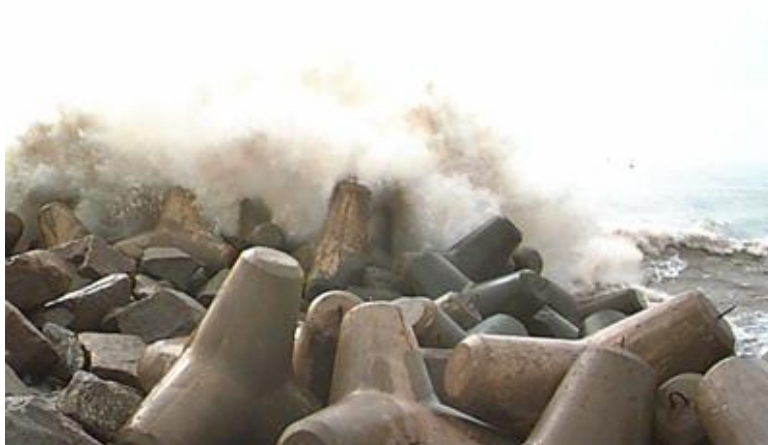
Fig. 2.2 – Blocos em sua função de proteção às ondas (GUIMARÃES, 2005).
