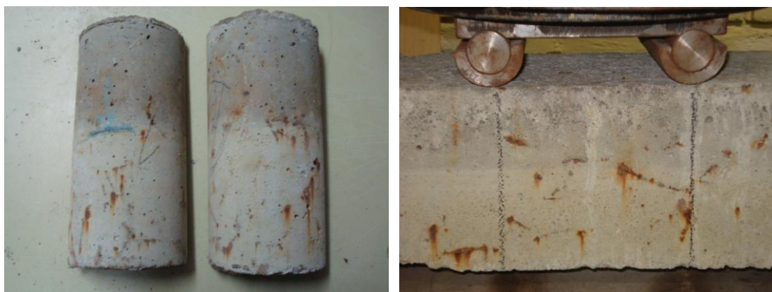
Fig. 4.1– Manchas superficiais no concreto após dois anos de ensaio.
