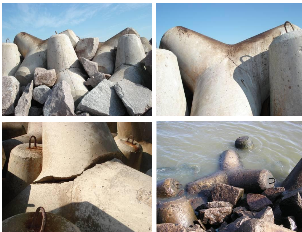
Fig. 2.22 – Fraturamento encontrado na junção das “pernas” (MIGLIORINI, 2007).
