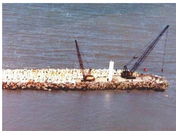
Fig. 2.11 – Instalação dos tetrápodes no molhe leste (RIO GRANDE VIRTUAL, 2009).
