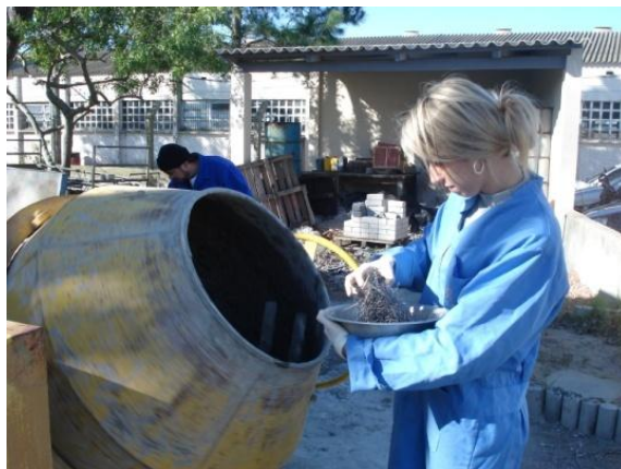
Fig. 3.15 – Inserção das fibras de aço ao concreto.
