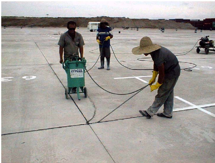
FIGURA 1.3 – Execução de pavimento portuário
