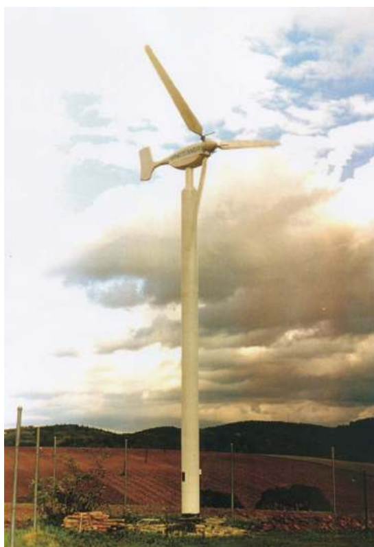
Figura 3.46 - Conjunto torre tubular de sustentação.e turbina eólica.
