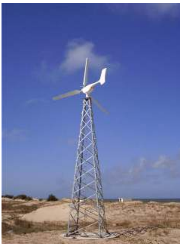
Figura 3.33 - Conjunto torre reticulada de sustentação.e turbina eólica
