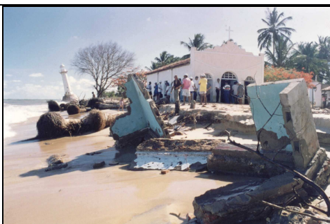
Figura 9. Igreja na Vila de Cabeço, com o farol já na linha de costa, em 1998. [1]
