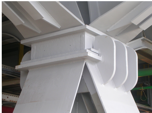
Figura 7: Detalhe do topo do stool do tipo deslizante.
