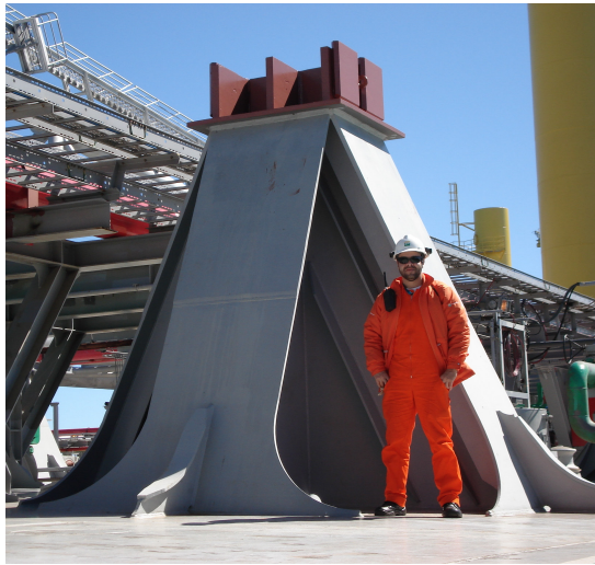
Figura 5: Stool (tipo fixo). Dimensões principais do stool da P-53.
