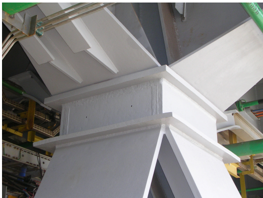
Figura 6: Detalhe do topo do stool do tipo fixo.
