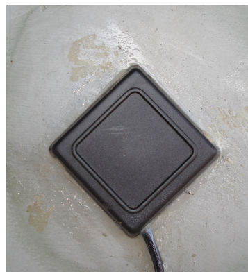
Fig. 9: Proteção adicional e acabamento (caixa 80 x 80 mm)
