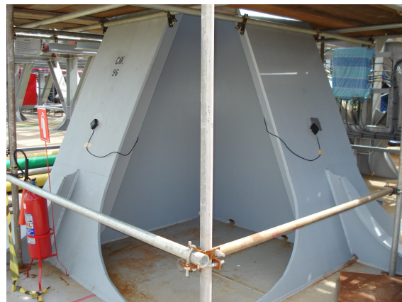
Figura 11: Foto do stool com os extensômetros instalados.
