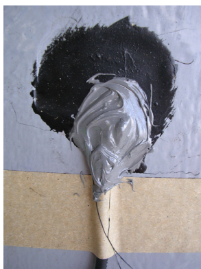
Fig. 8: Isolação e proteção mecânica
