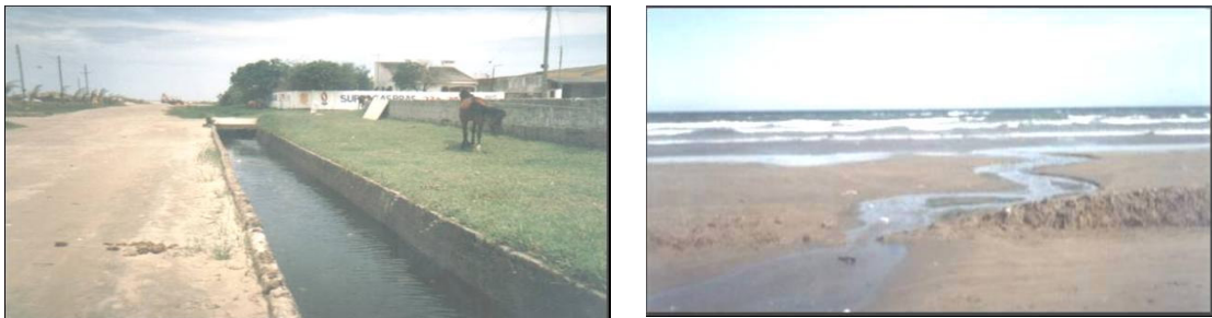
Figura 6 – Sangradouro que atravessa a Rua Rio de Janeiro ( S2 ) em sua trajetória pelo balneário.
