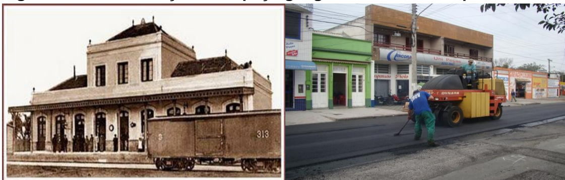
Figura 14 - Reconstrução do espaço geográfico – Rua Buarque de Macedo
