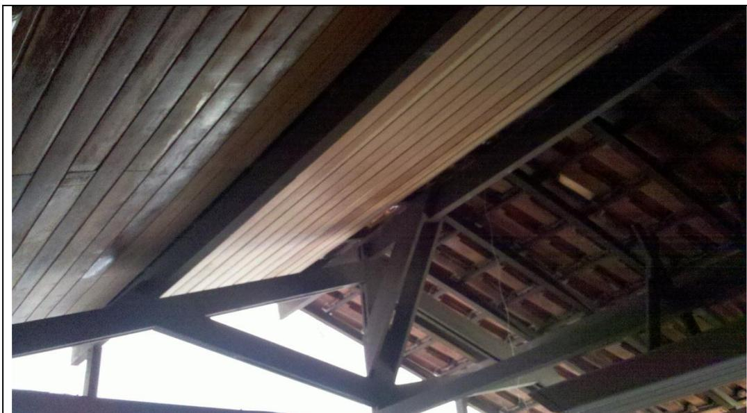
Imagem 9: Forro executado nas aulas de práticas construtivas
