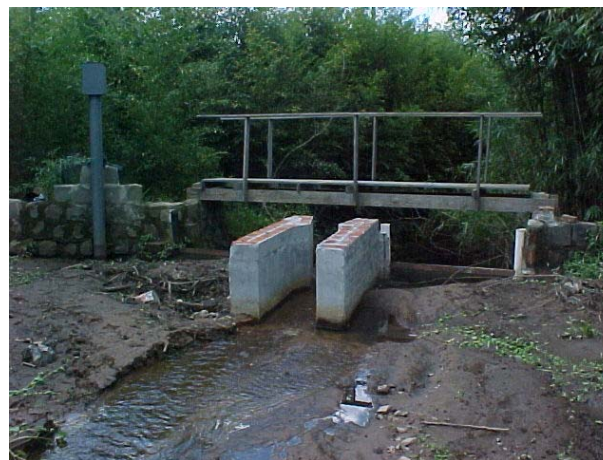
Figura 04. Calha 1 vista de montante
