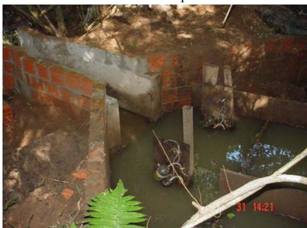
Figura 03. Calha 2 vista de montante
