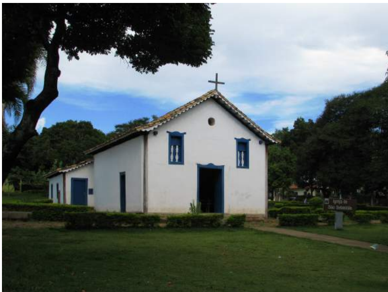
Figura 3: Capela de São Sebastião de Mestre d'Armas, construída em 1811, ampliada em 1880, reformada em 1911
