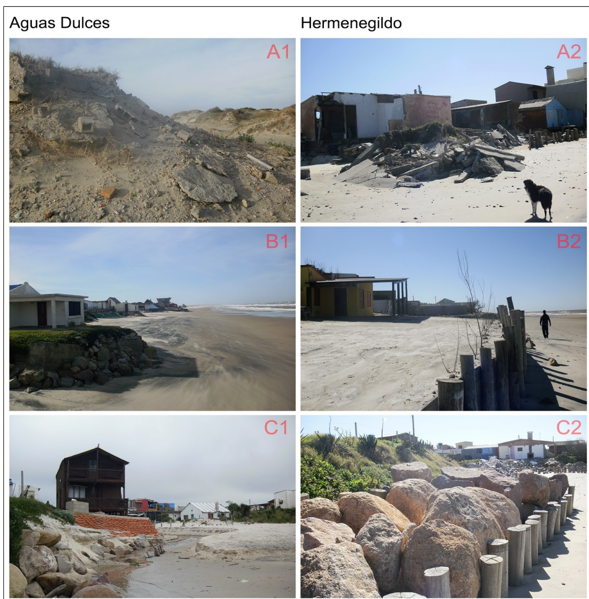
Figura 6.3.3.3: Padrões de intervenção identificados em Agosto de 2017: resíduos de construção (A1 e A2); projeção de construções na orla (B1) e a consolidação de aterros sobre o pós-praia (B2); readequação de sangradouros (C1) e reconstrução de estruturas de proteção costeira (C2).
