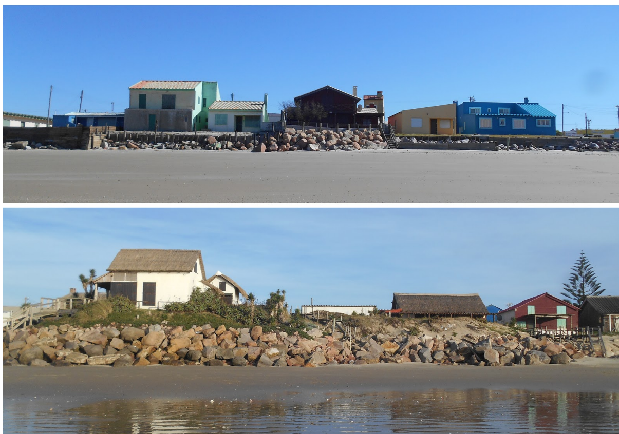
Figura 6.3.3.2: Estruturas mistas com muros de madeira e enrocamento no Hermenegildo (sup.) e estruturas híbridas com dunas vegetadas e enrocamento de Aguas Dulces (inf.) em Agosto de 2017.
