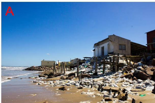
Figura 6.3.1.3. Erosão costeira em Aguas Dulces (Novembro de 2016): proteção com sacos de areia e postes de madeira (A), muros de concreto (B), lona e enrocamento (C), muros de madeira (D); escarpas erosivas em dunas (E, F e G); presença de minerais pesados e entulhos no pós-praia (H).
