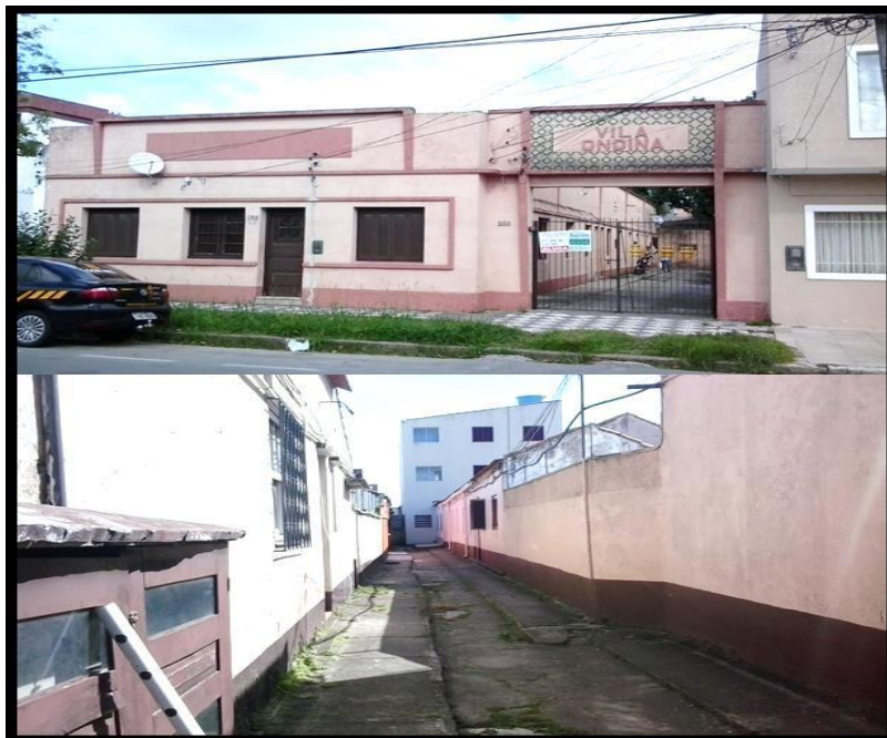
Figura 28: Em cima, Vila Ondina, rua Visconde do Rio Grande. Em baixo, vila de casas na rua Buarque de Macedo. Fonte: Foto do autor.
