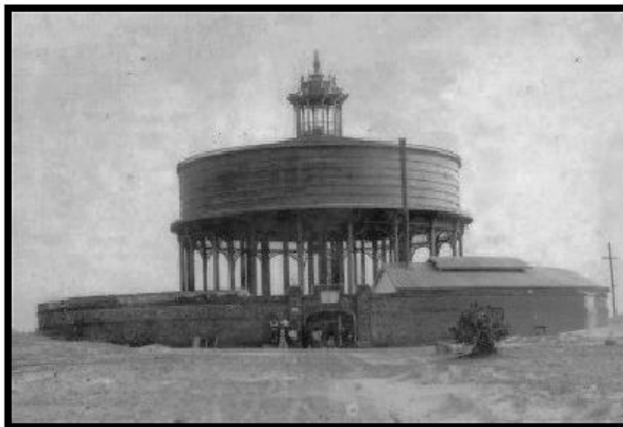
Figura 8: Caixa d'água da Companhia Hidraulica Rio-Grandense, construído em 1879, com material importado da Inglaterra, num terreno de 100 hectares, entre o saco da mangueira e o canal do Norte, a três quilômetros da cidade velha, hoje conhecido como bairro Hidráulica. Fonte: Arquivo Fototeca Municipal. Prefeitura Municipal do Rio Grande.
