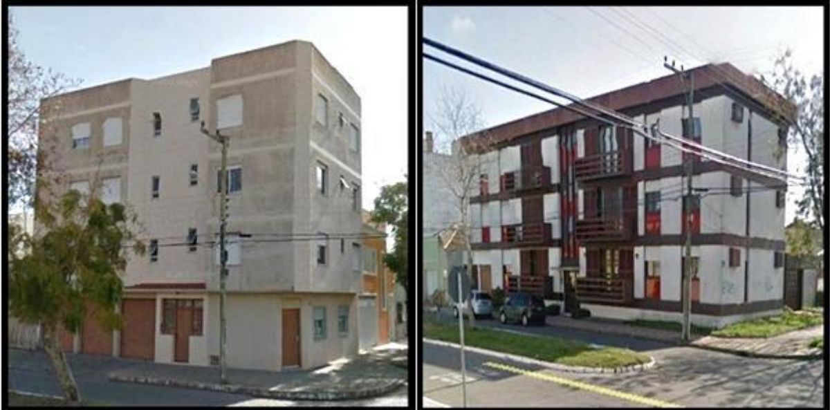
Figura 25: Edifício localizado na rua João Manoel esquina Mal Deodoro (esquerda) e Edifício localizado na rua Rio Branco esquina Visconde do Rio Grande. Fonte: Foto do autor.
